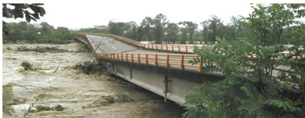
台風10号による増水で被災した橋（音更川）
